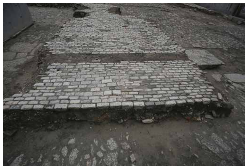
Figuras 21 e 22 mostram fragmentos (blocos testemunho) do Cais da Imperatriz com seu calçamento de paralelepípedos. Abaixo dele fica aparente o calçamento de pé de moleque pertencente ao Cais do Valongo. Fotos: João Mauricio Bragança, 2014 e 2015
