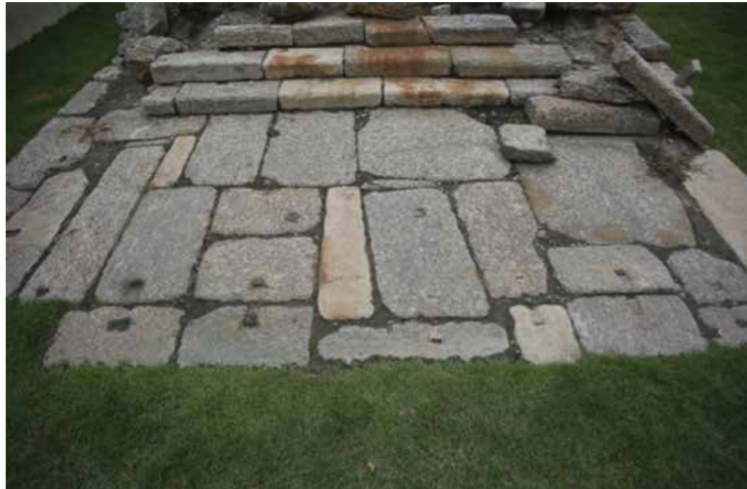
Figura 18. Cais da Imperatriz. Depressões para colocação de grampos para amarração das pedras. Foto: João Maurício Bragança, 2014
