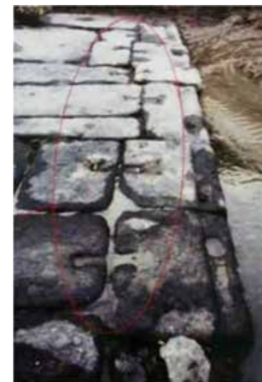
Figura 37 e 38: Grampos empregados na amarração das pedras, chamados de gatos metálicos no Caderno Técnico da empresa Retrô. Setembro de 2014 – p.16
