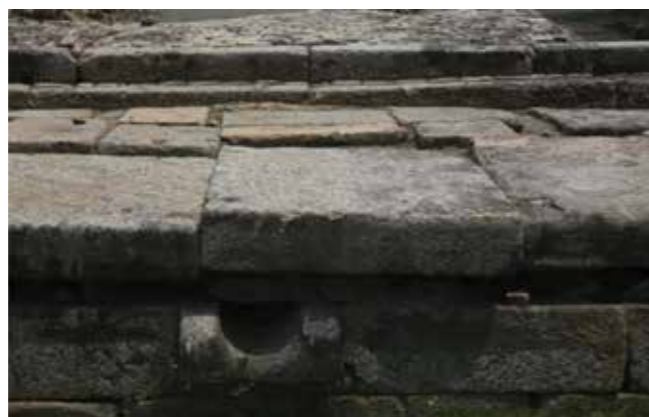
Foto 19 – Cais da Imperatriz. Bico para o escoamento de águas pluviais. Foto: João Mauricio Bragança, 2014
