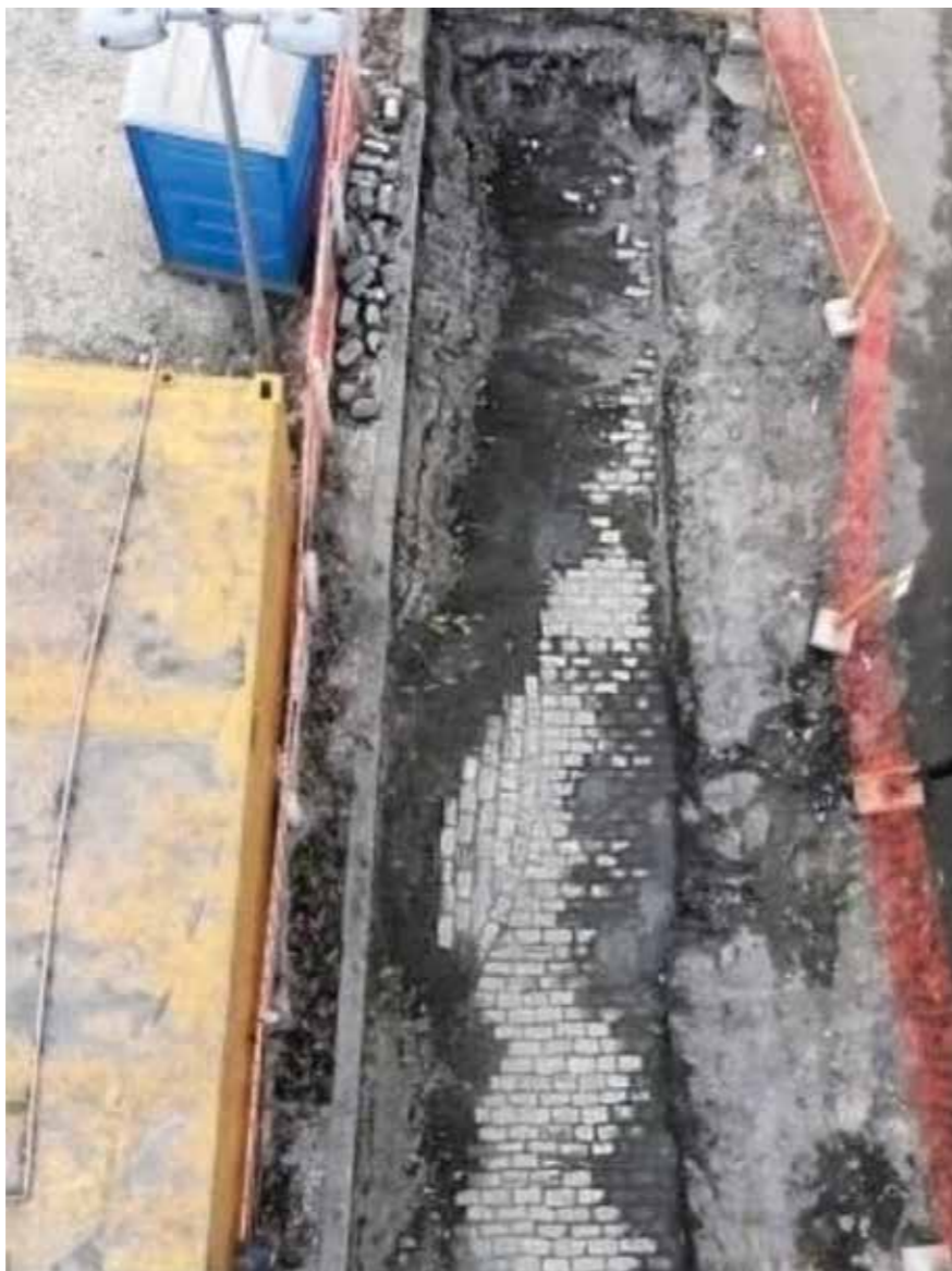
Figura 49. Trincheira 17, trecho do calçamento de paralelos removido quando das obras de melhoria realizadas na região.
