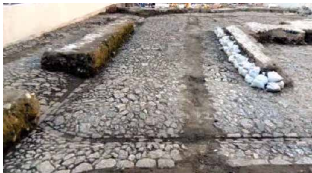
Figura 56. Rede de drenagem do Cais do Valongo. Fonte: Ibid., p.84
