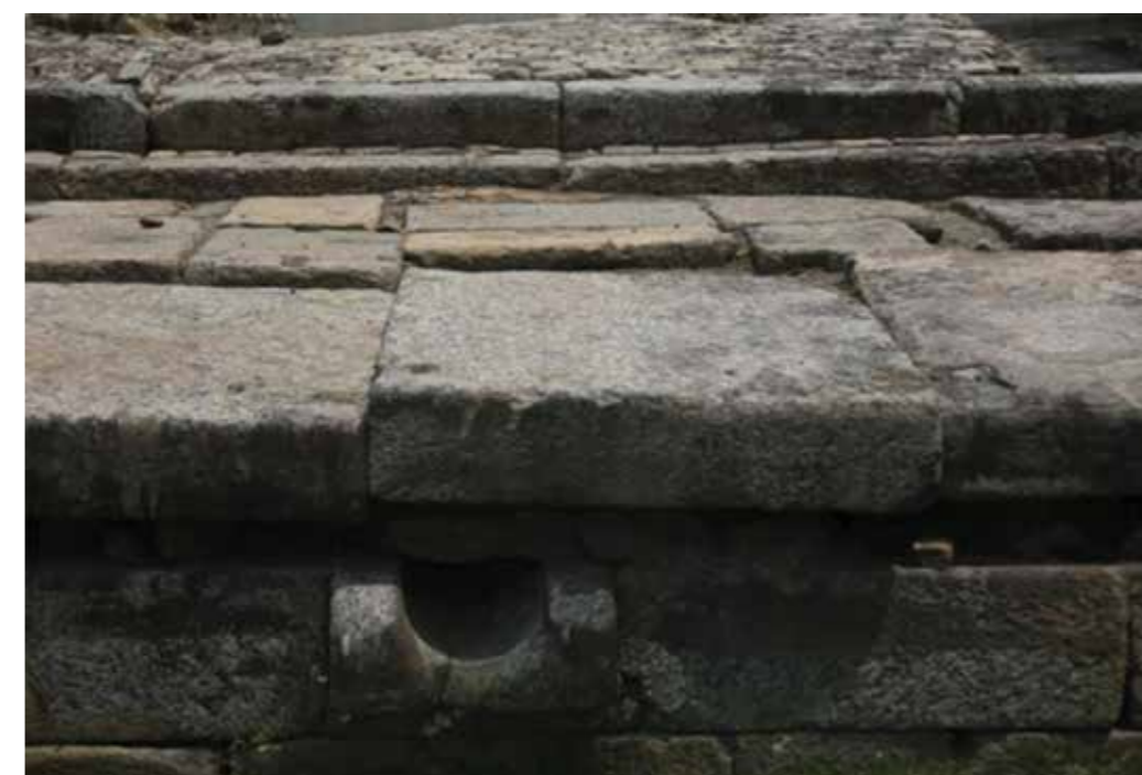
Figura 23. Cais da Imperatriz. Bica para deságue das águas pluviais. Foto: João Mauricio Bragança, 2014
