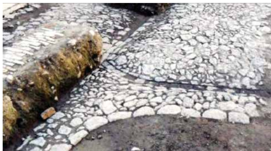
Figura 54. Arremate e drenagem descritos acima.
