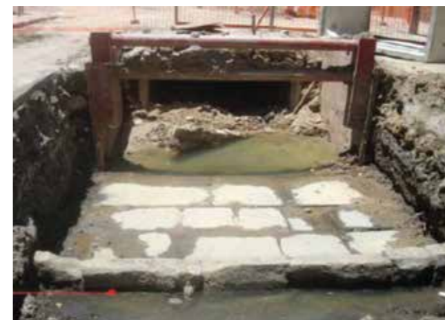
Foto 22 - Blocos de lajes revelados em Frente 1 / Trecho 1. Fonte: ANDRADE LIMA, 2013, p.15
