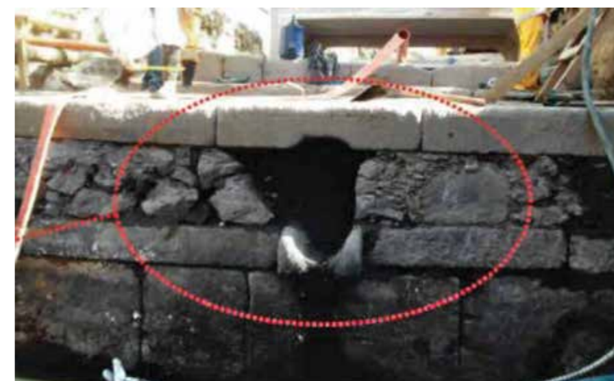
Figura 30. Local de desague em meio às pedras costaneiras (lavradas) do Cais da Imperatriz. Fonte: Ibid., p. 36
