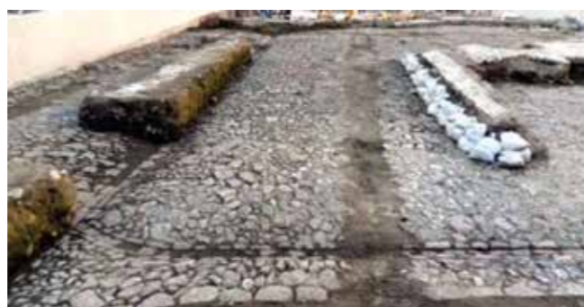
Foto 44 - Rede de drenagem de água para o Cais do Valongo. Fonte: Ibid., p.84
