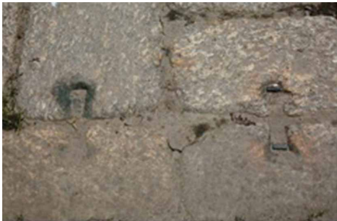
Figura 19. Cais da Imperatriz. Detalhe dos vestígios dos grampos para amarração das pedras. Foto: João Maurício Bragança, 2014
