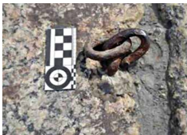
Foto 32 - Anel de amarração em metal ferroso exposto aos agentes atmosféricos anexos a borda da alvenaria. Fonte: ANDRADE LIMA, 2013
