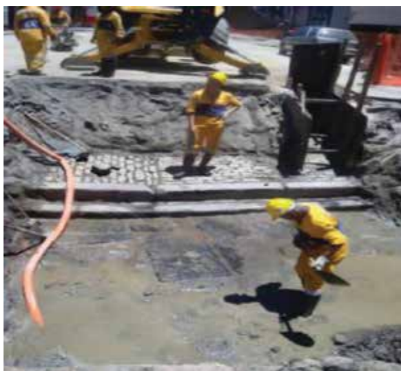
Foto 25 - Lajes, degraus e calçada pavimentada de paralelepípedos revelada na frente 2.
