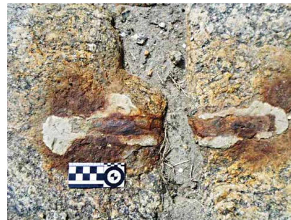
Figura 39. Marca de oxidação no entorno dos vestígios de gato metálico ferroso. Foto: Acervo Retrô, Setembro de 2014 – p.16
